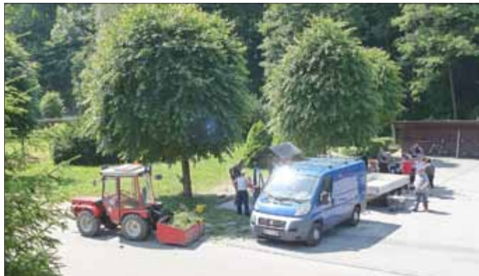
Pflastern der Kegelbahn am Parkplatz
