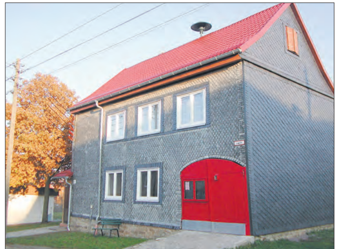
Dach- und Wandsanierung Gemeindesaal Aschau
